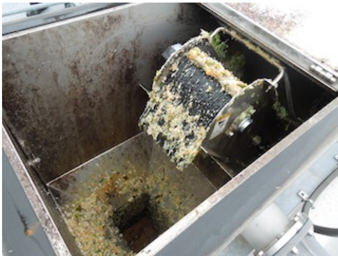
脱水機から槽内へ
